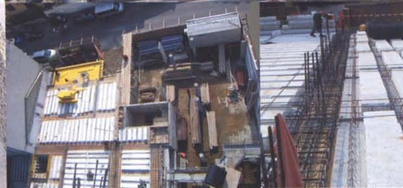
**Fasi di realizzazione dei solai.** I livelli basamentali sono costituiti da solai predalles, mentre quelli della parte superiore da strutture in laterocemento. Questi ultimi presentano, in ragione degli aggetti e delle luci piuttosto consistenti, travi in spessore con larghezze che superano il metro.
