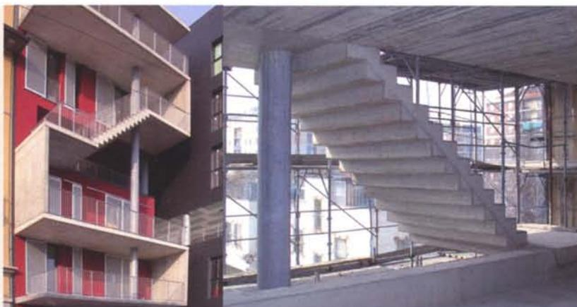
ventato da pareti piene portanti in calcestruzzo armato. Una parte delle strutture di elevazione, quelle lasciate a vista, sono realizzate impiegando casseri metallici al fine di migliorare la qualità estetica della finitura del calcestruzzo. Analogamente, le colonne portanti poste in facciata sono realizzate ricorrendo a tubolari metallici utilizzati come cassero a perdere.
