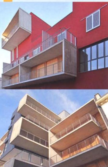
Sopra: le ampie cornici in calcestruzzo a vista oltre a "movimentare" le volumetrie e a garantire ulteriori spazi agli alloggi, hanno anche il compito di proteggere la facciata da un eccessivo irraggiamento.
